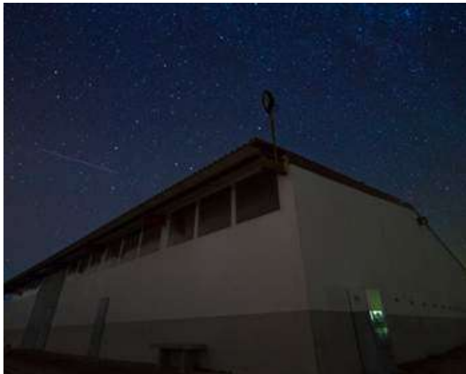
Foto | Instalaciones junto a el Parque Periurbano de San Isidro. Dos Torres.
