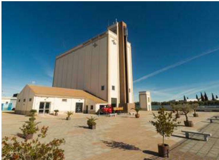
Foto | Antiguo silo en Alcaracejos, actual centro termal.
